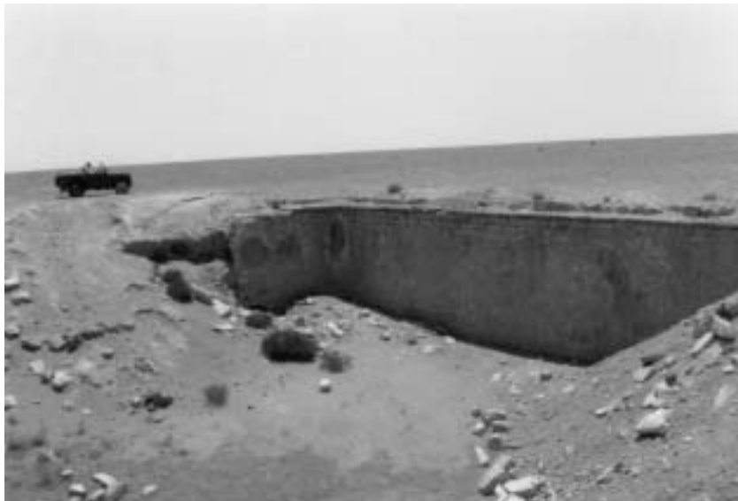
Fig. 10 Qasr Mushash, citerne maçonnée umayyade partiellement détruite au bulldozer.
