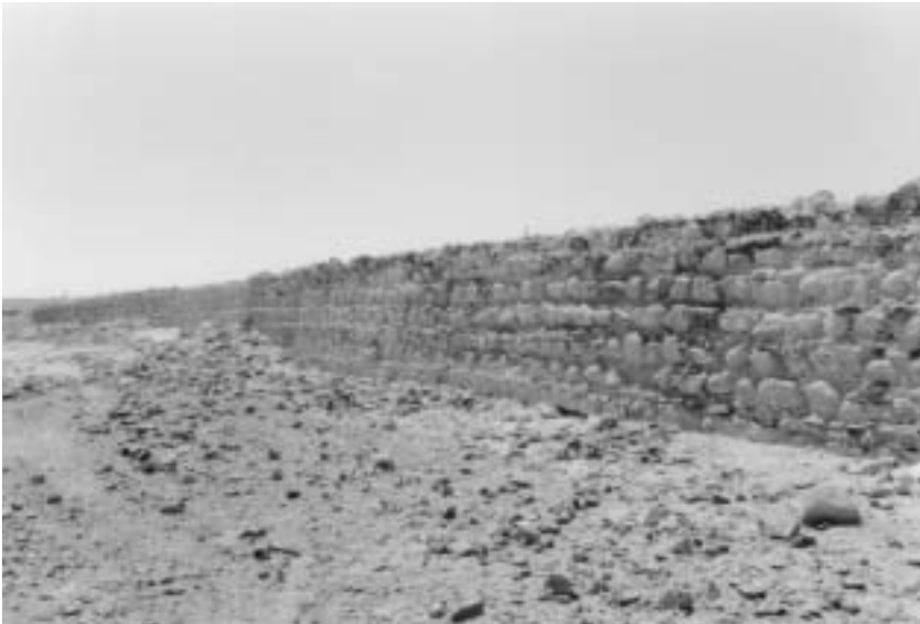
Fig. 12 Ma'an, aqueduc d'al-Hammam.
